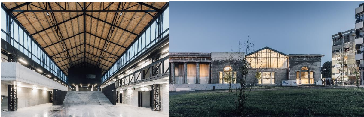
Bâtiment « Maçonnerie » - Campus UCharleroi
