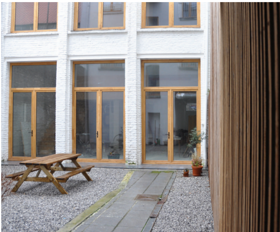
Co-housing Ribeaucourt (Molenbeek, België) | PT Architecten i.s.m. Bureau Bas Smets
