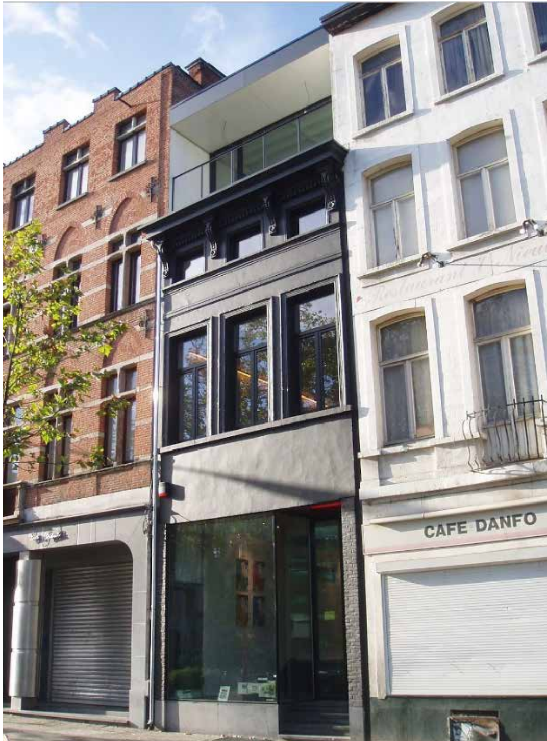
De Coninckplein 11-23(Antwerpen, België) | AG Vespa Polyvalente ruimte (gelijkvloers) en woonproject (verdiepen).
