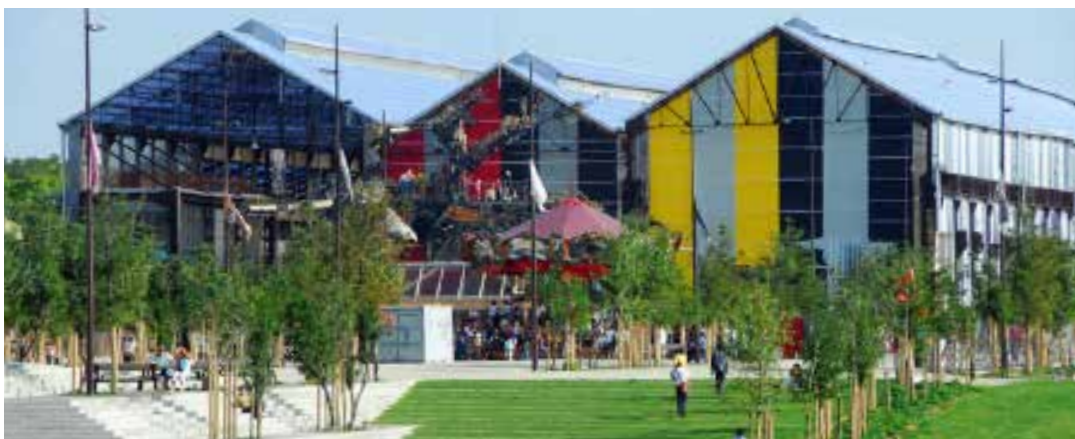
Les nefs (Île de Nantes, France) | Alexandre Chemetoff & associés Verwerking van les Nefs op de site van de maritiemeschepen.
