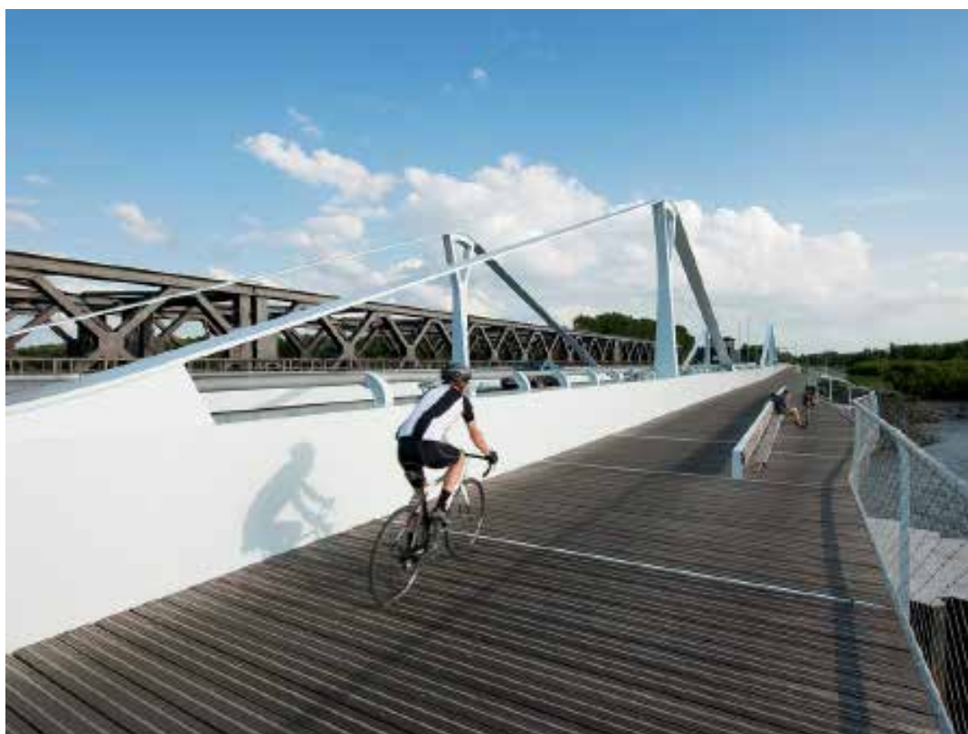
2e Scheldebrug (Temse, België) | Ney & Partners Verblijfskwaliteit fietsersbrug optimaliseren.
