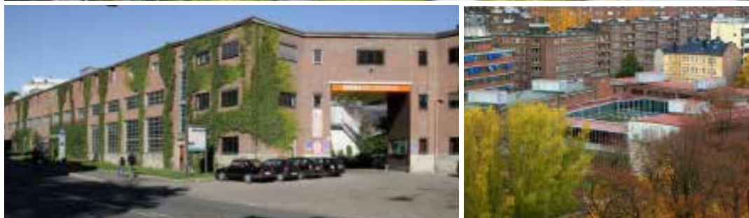
AHO School of Architecture and Design (Oslo, Noorwegen) | Jarmund/Vignæs AS Architects MNAL De school is een omgevormd fabrieksgebouw, vernieuwd en gemoderniseerd.
