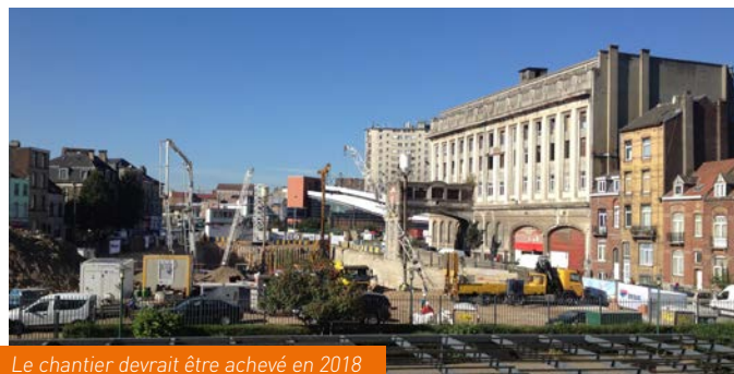
Le chantier devrait être achevé en 2018 De werf zou moeten voltooid zijn in 2018
