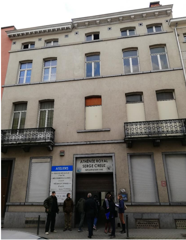
Gevel van het gebouw in de Piersstraat
