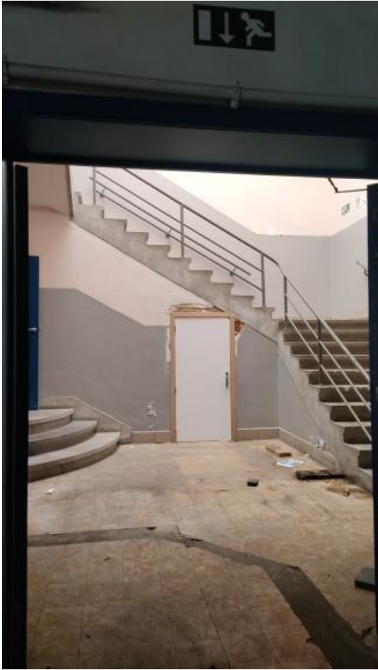
Trappenhuis van de gelijkvloerse verdieping naar de bovenverdiepingen.
