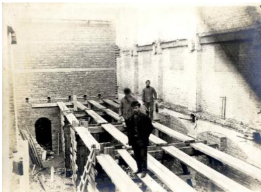
Sur le chantier de la minoterie Farcy, début 20e siècle (Coll. Fr. Farcy)
