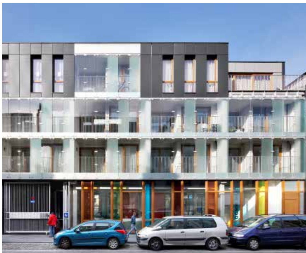
Crèche Savonnerie Heymans (Anderlecht, Belgique) | MDW Architecture
