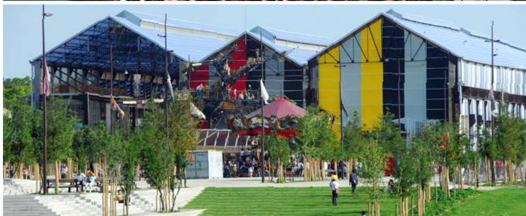
Les nefs (Île de Nantes, France) | Alexandre Chemetoff & associés Réhabilitation des Nefs du site des Chantiers navals.
