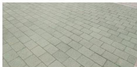
Parking PMR en pavés de béton poreux
