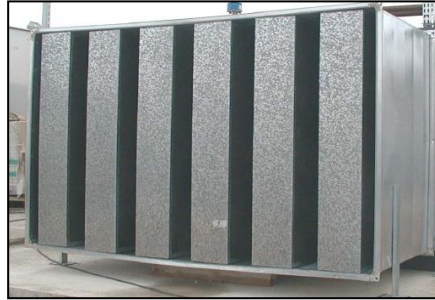
Figure 6 : Exemple de silencieux à baffles parallèles
