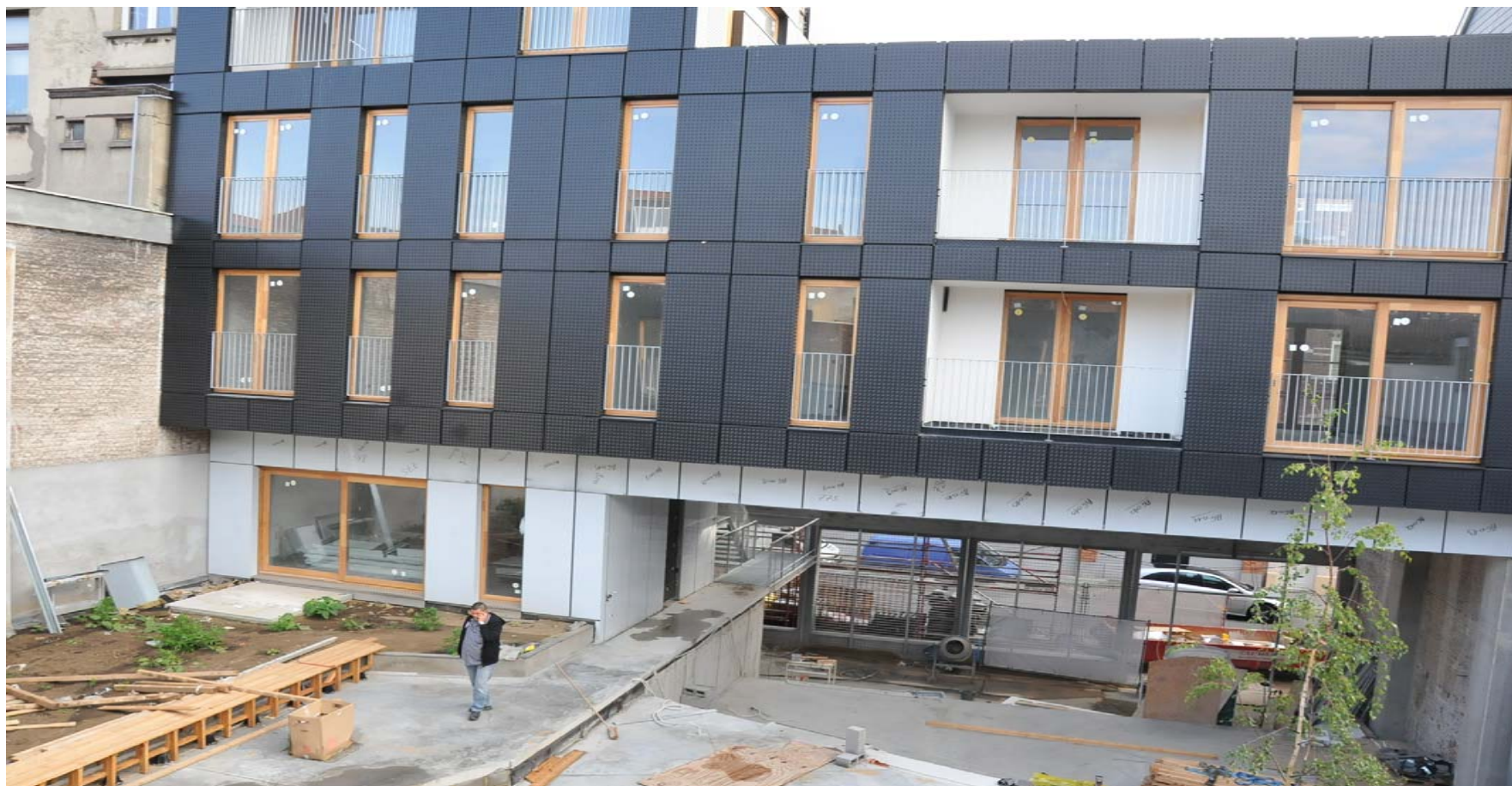
Réalisation rue Le Lorrain – Contrat de quartier Maritime
